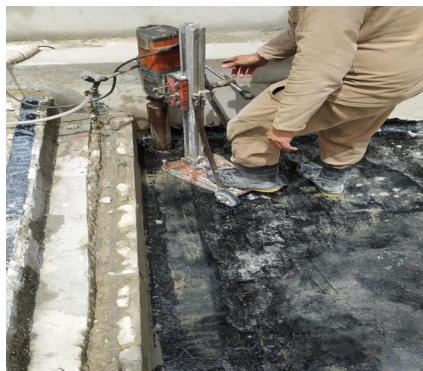
► Figura 3: Execução dos furos de drenagem da piscina
