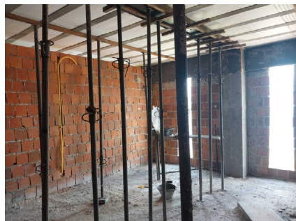
► Figura 1: Escoramento na obra da câmara municipal
