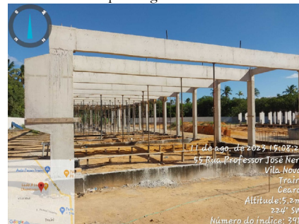
► Figura 4: Retirada das escoras das vigas da escola de tempo integral
