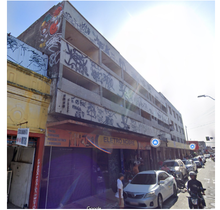
► Figura 10: Edifício na .
