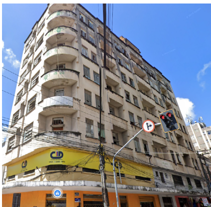
► Figura 6: Edifício na Rua Pedro I, 495.
