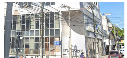
► Figura 3: Edifício na Rua Senador Alencar, 80.
