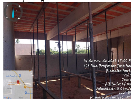
► Figura 3: Escoramento na obra da escola de tempo integral
