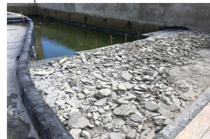
► Figura 6: Retirada do contrapiso e do emboço da piscina
