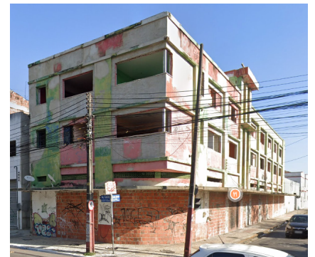
► Figura 11: Edifício na Rua Solon Pinheiro, 261.
