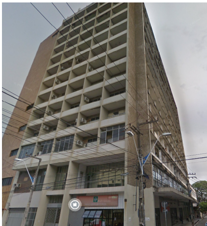
► Figura 5: Edifício na Rua Castro e Silva, 120.
