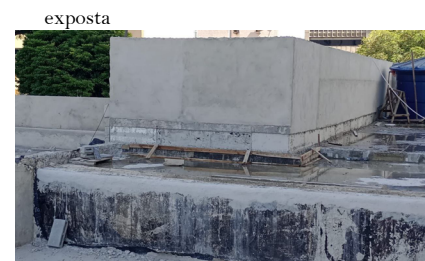
► Figura 1: Impermeabilização da piscina
