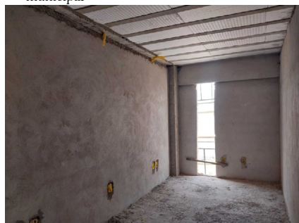
► Figura 2: Retirada do escoramento da câmara municipal
