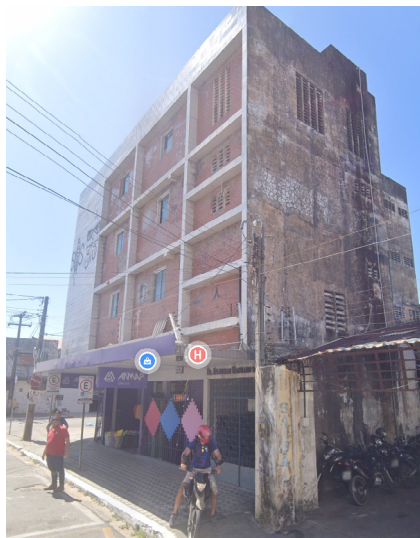
► Figura 9: Edifício na Rua São Paulo, 459.
