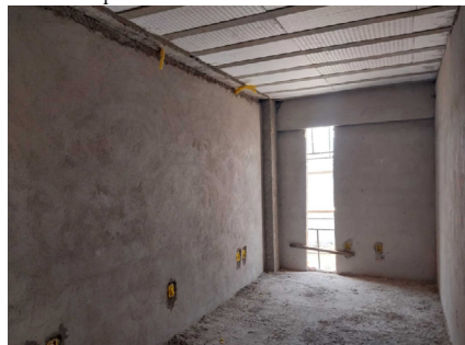
► Figura 2: Retirada do escoramento da câmara municipal
