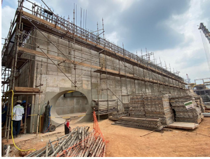
► Figura 8: Desfôrma - britagem
